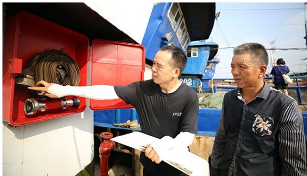
检查消防设备
