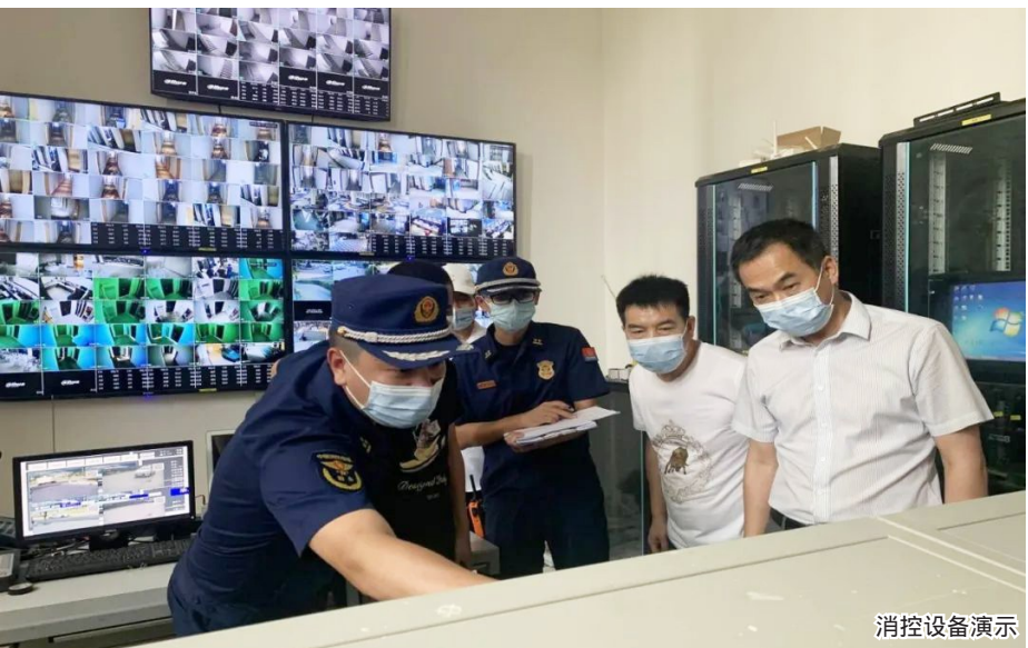
消防控制室设备演示
