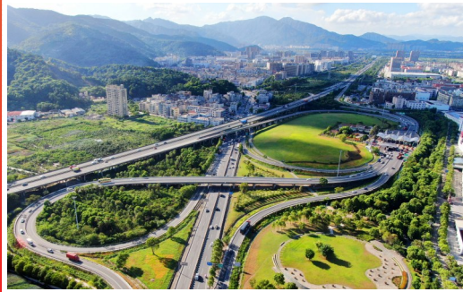
沈海高速塘下枢纽(陈立波 摄)
