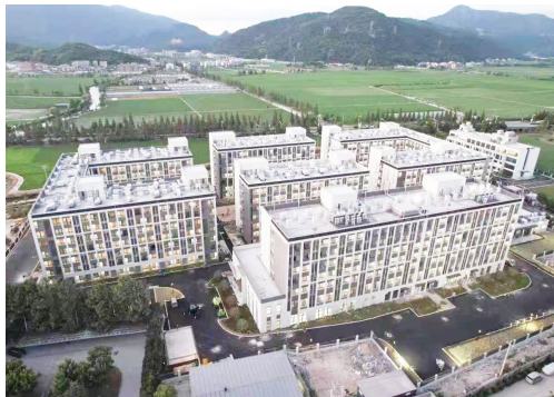
市保障性租赁住房竣工
