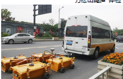
道路脱空检测
