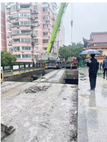
塘河南路2号桥维修
