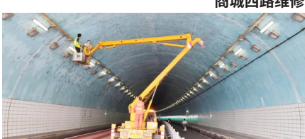
万松山隧道“体检”
