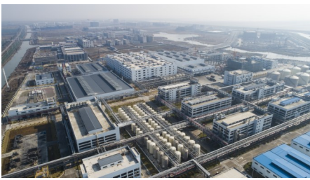
华峰新材料产业园一期
