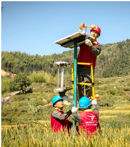
供电公司红船党员服务队开展隐患排查
