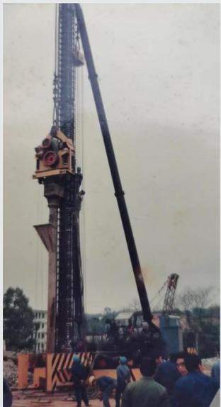
木云荪团队设计、制造的新型振动混凝土灌注桩机
