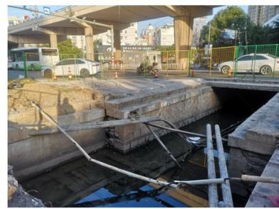
围挡设施设立、原旧桥板拆除等工作。“这两天我们在装沙袋,准备围堰后抽空桥下河水,查看桥台(水面下)是否有破损。”现场技术负责人尤春峰说。
