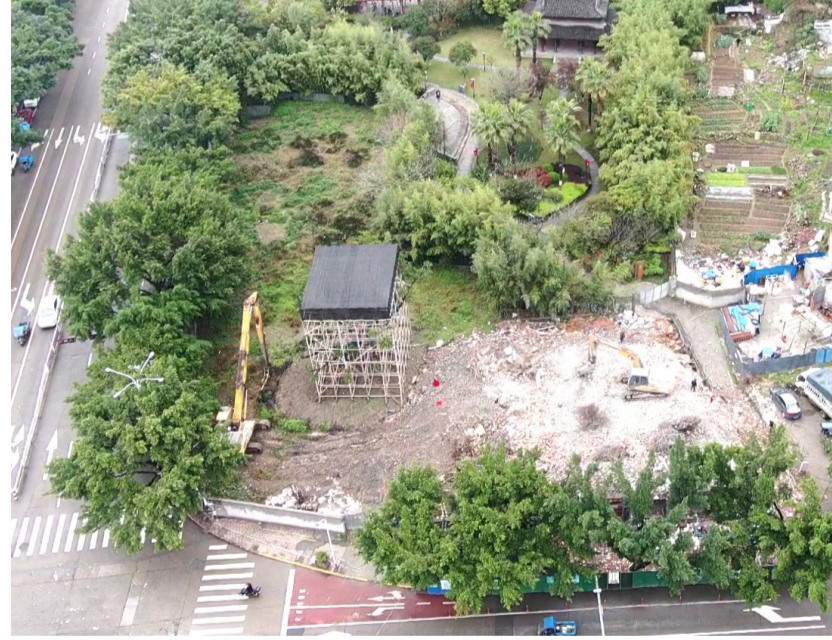
环隆山团块拆改项目拆后现场
