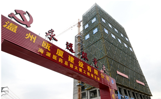
在建的总部大楼
