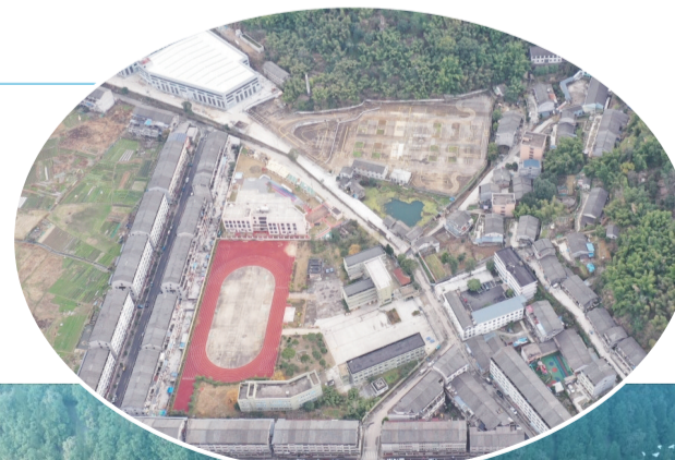
平阳坑镇老旧工业点改造提升现状
