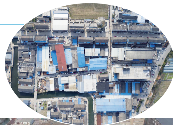
杏里村老工业产业园拆前
