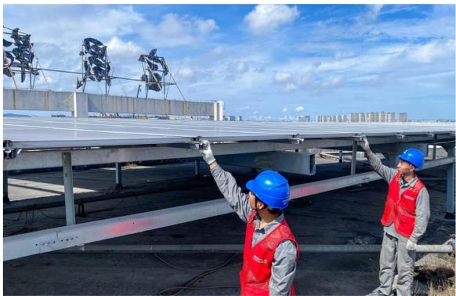
本报讯(通讯员 陈辰洲 记者 陈浩)为防止台风天因暴雨引起的设备短路,7月24日上午,温州华电实业有限公司积极采取应急措施,由综合能源中心派出专业运维队伍,对光伏电站内光伏板及相关设备进行巡检加固消缺。
