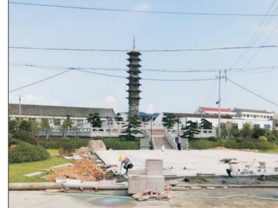
垟坑龟山公园改造前
