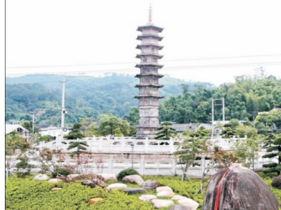
垟坑龟山公园改造后
