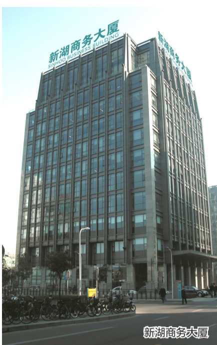
华峰集团工业园区
