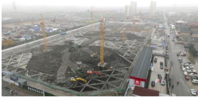
车辆的轰鸣声、挖掘机的作业声、机械的敲击声,谱写成一篇独特的新春工地乐章。目前复工情况还是比较不错的,已有63名工人到岗,工地内现投入了28辆工程车、8台挖机,正在进行地下室土方开挖施工,复产能达到80%以上。莘塍中单元02-17地块建设单位项目负责人周王颌说。
