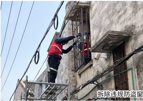
拆除违规防盗窗
