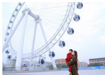
4月3日上午，瑞安首座滨水摩天轮“瑞安之眼”开始运营。“瑞安之眼”总投资1200万元，总高62米，采用单边二立柱无横撑大立架结构设计，纯辐条转轮，有32个球型轿厢，每厢可坐6人，每次最多可运载192人，运营时间为10时至22时。
