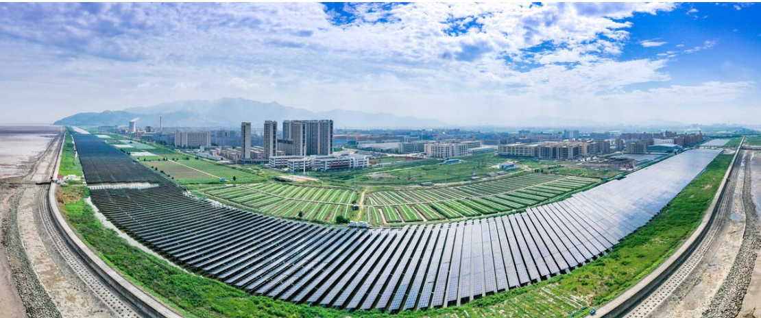
浙南产业集聚区瑞安阁巷分区内的40MW渔光互补光伏电站
