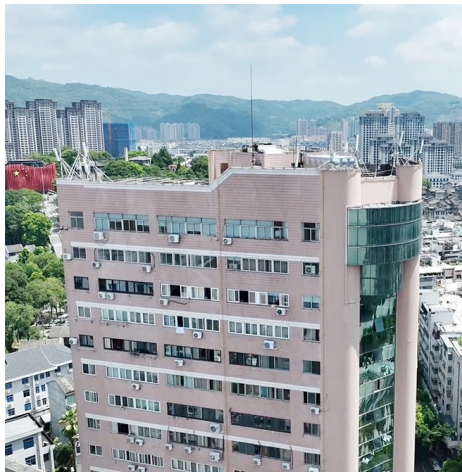
需燃气管道改造的商会大厦
