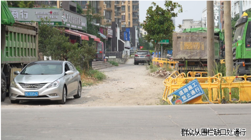
导航路施工停滞
