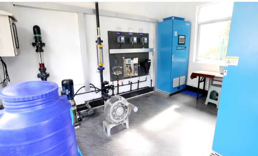
改造提升后的燕子窝供水站
