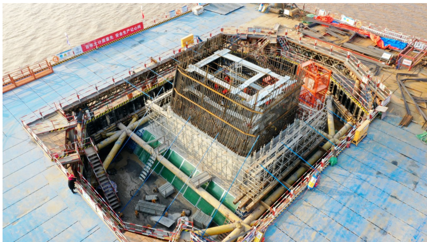
飞云江一号特大桥施工现场
