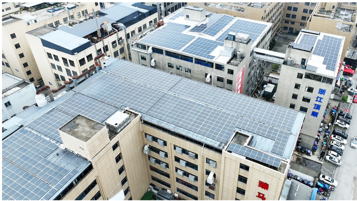
厂房屋顶光伏板
