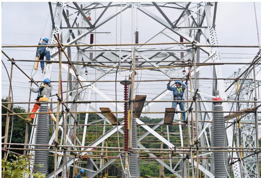
电力工作人员在进行线路架设工作
