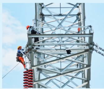
电力施工人员开展组塔架线作业
