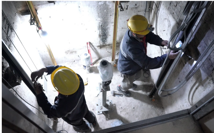
工人进行电梯底坑缓冲器安装作业
