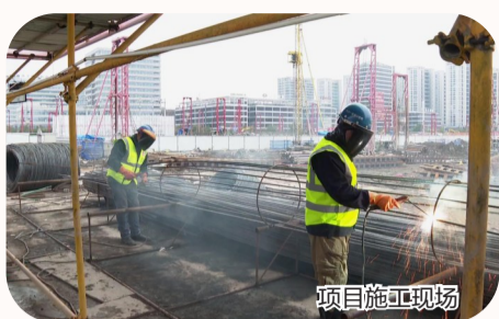
项目施工现场
