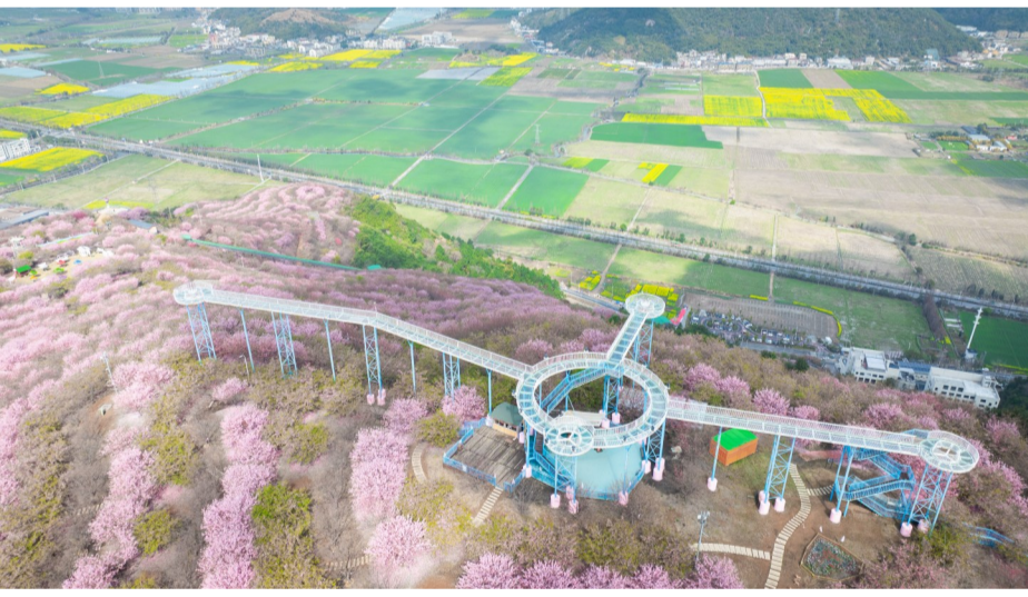
凤凰樱花谷玻璃栈道观景平台
