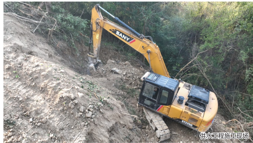
供水工程施工现场
