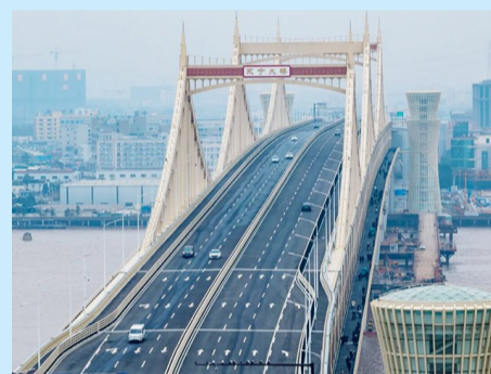
永宁大桥正式通车(孙瀚摄)
